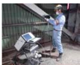
構造物検査の例
